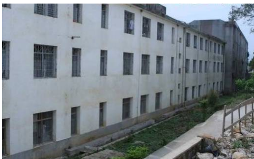
学生宿舍防盗网改造已完成
